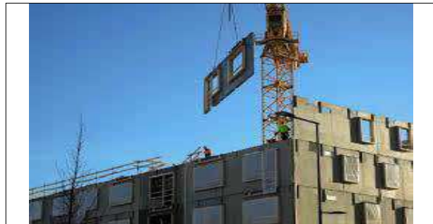
شکل ۳: استفاده از تکنیک قطعه‌بندی در صنعت ساخت و ساز برای کاهش هزینه و افزایش سرعت
